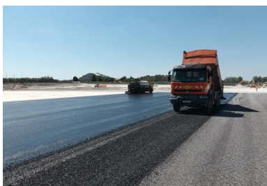
Atelier de mise en œuvre de l'enduit bicouche clouté dont le rôle est d'assurer la protection du sol traité. (© Colas)
