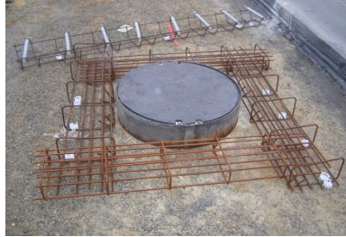
Chaînage bordant un regard.
