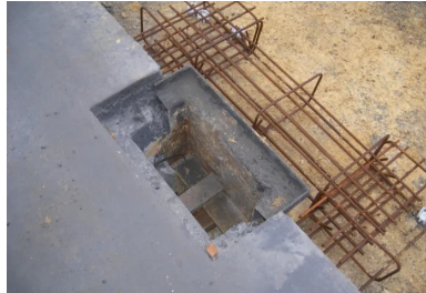
Chaînage autour d'un avaloir.
