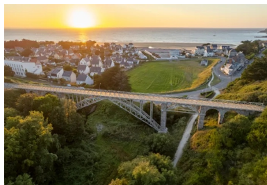
D'une longueur totale de 109,25 m, le viaduc de Caroual, situé à Erquy (22), comprend un arc central de 45 m de portée en béton armé. Il a été restauré en 2021. (© Pierrick Menard)
