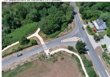
Le carrefour d'entrée RD198-RD198A, avant et après les travaux de rénovation. (© département du Morbihan) (©Phytolab)
