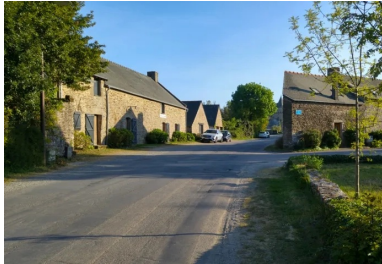
Le hameau de Kermoizan au niveau de la ferme transformée en bureau d'accueil et de billetterie avant aménagement. (©Phytolab)
