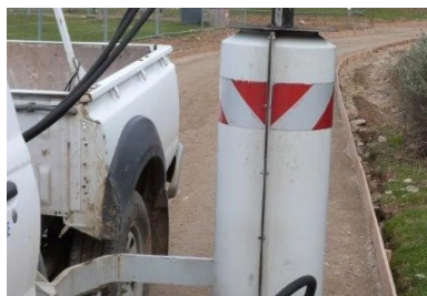
Vérification de la portance de la plate-forme support à la dynaplaque. (©CIMbéton)
