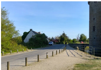
Le parvis du château de Suscinio, avant les travaux d'aménagement. (© Phytolab)
