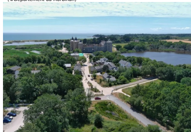
La traversée du hameau de Kermoizan, après les travaux d'aménagement. (© Phytolab)
