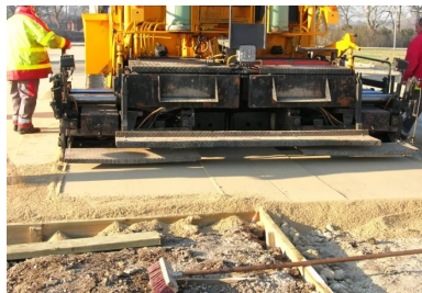
Mise en œuvre par bandes du sable stabilisé au liant Stabex au finisseur. (© CIMbéton)
