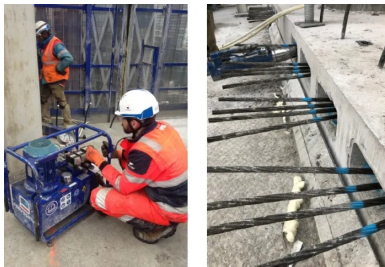
Tour Hekla – La Défense. Après que le béton a atteint une certaine résistance, les câbles sont tendus à l'aide d'une pompe hydraulique (à gauche). Lors de cette étape, l'extrémité libre de chaque câble est tirée par des vérins vers l'extérieur, ce qui a pour effet de comprimer le béton entre les points d'ancrage des câbles. Un effort de 22,3 tonnes est appliqué sur chaque câble. © FREYSSINET
