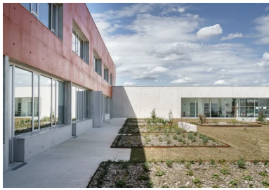
Les classes élémentaires s'ouvrent à l'est sur le calme du patio.
