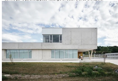
L'avancée du volume du premier niveau est portée par 2 poteaux en béton, inclinés en V, qui signalent la séquence d'entrée de l'école élémentaire.
