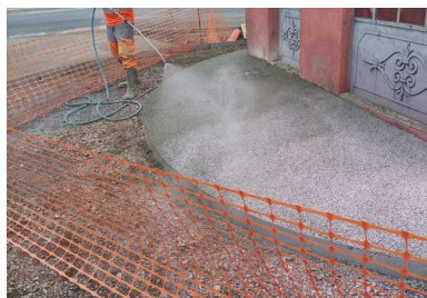
Pulvérisation du produit dénuant Agent dénuant Via Stone® Drain. (©Jean-Sébastien Deborde, Ingepro).
