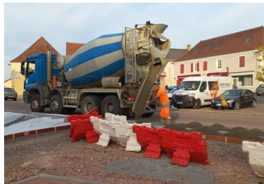
Le béton drainant est déversé entre coffrages sur la plate-forme support. (©Grégory Charpenet, Béton Vicat).
