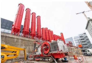
Du fait de l'exiguïté de la parcelle, la totalité des installations nécessaires au traitement, au recyclage et au stockage de la boue bentonitique ont été implantées en surélévation de l'emprise. C'est une paroi berlinoise qui assure la stabilité du dispositif.
