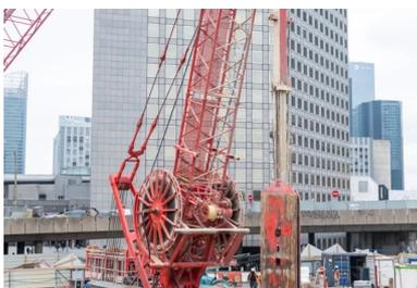
Vue d'une benne preneuse hydraulique. Cette machine était utilisée pour l'excavation des sols meubles. Pour les sols plus durs, elle était remplacée par une hydrofraise, une hacheuse de paroi mise au point par Solétanche-Bachy.
