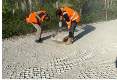
Contrôle de l'épandage du liant à l'aide de la méthode dite à la bêche. (© Jacob Gouvenaux_Braja Vesigne).
