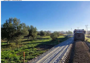
La malaxeur moderne Wirtgen WR 240 mélange le liant LVT5 13 avec le sol intimement sur une épaisseur foisonnée de 35 cm. (© B. Montagnini _Ecostab)
