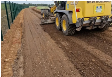
RÉGLAGE FIN DE LA PLATE-FORME TRAITÉE A L'AIDE D'UNE NIVELEUSE. (© B. MONTAGNINI _ECOSTAB)
