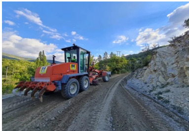
Le pré-réglage du matériau traité à l'aide d'une niveleuse, avant le compactage. (© B. MONTAGNINI _ECOSTAB)
