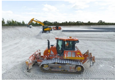
Extraction de la craie et constitution d'une zone de dépôt provisoire. (© Colas)
