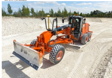
Préréglage de la couche de forme à l'aide d'une niveleuse. (© Colas)
