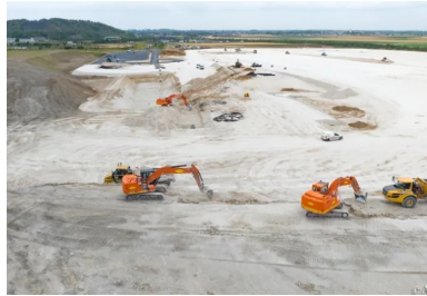
Vue générale du chantier de terrassement, conçu en circuit fermé déblais-remblais. (© Colas/ArtoisDrones)
