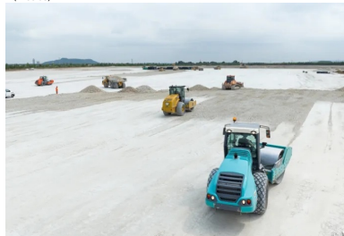
Acheminement de la craie et mise en œuvre de celle-ci en couches de 40 cm et 50 cm. (© Colas)
