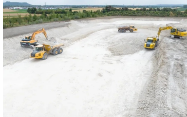
Reprise sur stock à l'aide d'une pelle sur chenilles et de tombereaux articulés. (© Colas)
