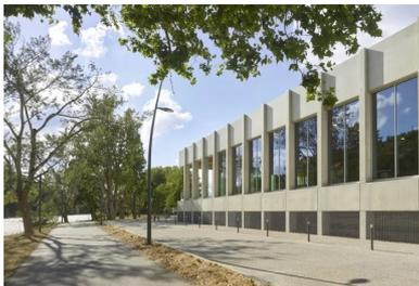
Vue de la façade sud de la halle des bassins. Elle est rythmée par des poteaux porteurs en béton, de 30 cm x 50 cm, espacés selon un pas de trame régulier de 2,55 m et surmontés par une poutre de couronnement, elle aussi en béton. L'ensemble exprime la grille constructive du projet, dessine son enveloppe et lui confère son identité.
