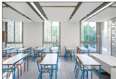
Comme une réinterprétation du modèle du cloître, la lumière est adoucie par le filtre que constituent les panneaux en béton fibré.
