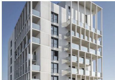
Les ondes verticales du béton matricié ajoutent rythme et vibrations aux façades des logements.
