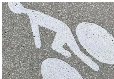
Un des intérêts du béton est de permettre d'imprimer par la méthode du pochoir des dessins durables en surface.
