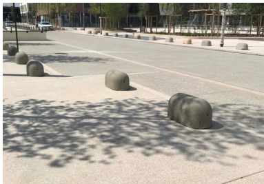
Les bétons ont été formulés afin d'obtenir les nuances visées (du blanc chaud au beige clair) afin de s'harmoniser avec la couleur de la pierre calcaire du comblanchien.
