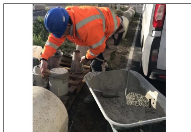
Contrôle qualité du béton frais.
