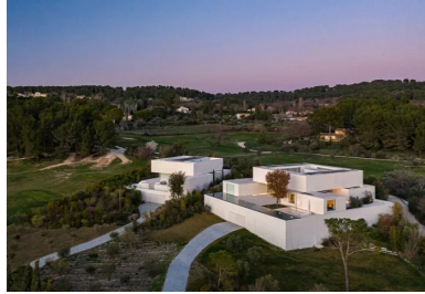
Les volumes en béton blanc des villas émergent de la végétation méditerranéenne.
