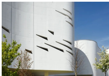
Les façades béton sont griffées de petites percées qui apportent un éclairage naturel sans dévoiler.
