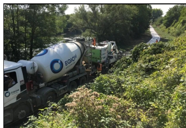
Le béton fabriqué à la centrale d'Illange d'EQIOM est livré par camions-toupies devant la machine à coffrages glissants.
