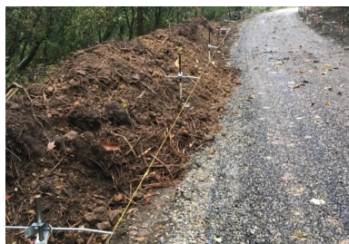
Couche de forme avec enduit de protection prête à recevoir le revêtement en béton. Fils de guidage de la machine à coffrages glissants déjà en place.
