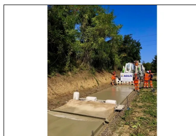
La machine à coffrages glissants, tractant la toile de jute, assure simultanément la réalisation du revêtement en béton et le traitement de surface.
