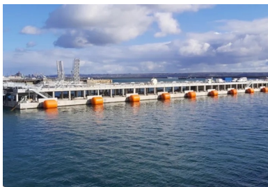
Vue générale du ponton flottant, de la passerelle métallique de liaison au quai (à gauche) et du musoir (à droite), qui constitue le point fixe d'accostage et d'amarrage des frégates côté mer.
