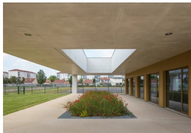
En façade ouest, un débord plus large de la toiture fabrique un auvent et génère un effet d'appel qui signale la présence du restaurant scolaire ainsi que son entrée. Il fait également office de préau.
