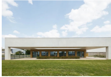
L'attique et les quatre poteaux d'angle dessinent comme une table en béton clair, sous laquelle s'organise en retrait l'ensemble du programme.
