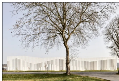
Les façades de la salle sont réalisées avec des panneaux préfabriqués en béton blanc de type mur à coffrage intégré (MCI), qui assurent de façon performante la protection acoustique de l'environnement extérieur.
