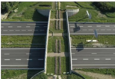
Vue aérienne du passage à faune de Moirans, sur l'A48. © Romain Courtaud
