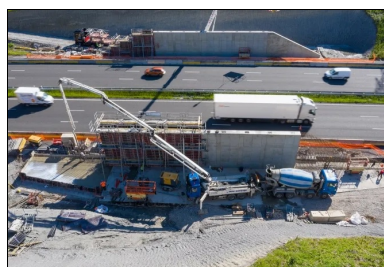
Passage à faune « Porte de Savoie » à Chignin, sur l'A43. Bétonnage des culées. © Régis Bouchu ACTOPHOTO
