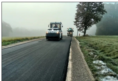
Atelier de compactage du BBCS.
