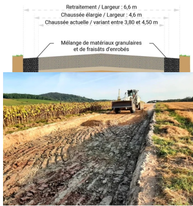
Travaux de remblayage des purges effectués en pleine largeur.
