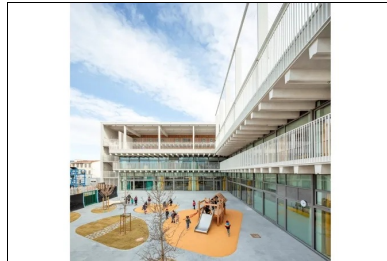
De grands châssis coulissants permettent d'ouvrir de plain-pied les locaux sur la cour de la maternelle ou un large balcon au 1er étage.
