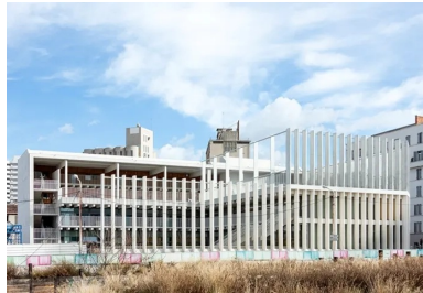
Côté mer, les écoles superposées et leurs cours au rd+ et au R+2 s'ouvrent sur le paysage à travers le rythme de la colonnade, à la fois protectrice et poreuse.
