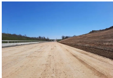
La liaison entre Toulon-sur-Allier (Allier) et Digoin (Saône-et-Loire) fait appel massivement à la technique de traitement des sols en place au filant hydraulique routier LHR.
