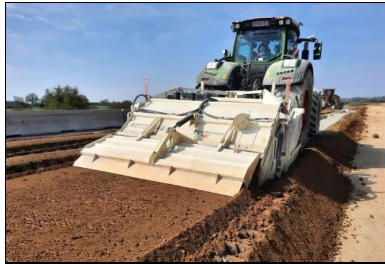
Le matériau et le liant sont malaxés à l'aide d'un malaxeur tracté.
