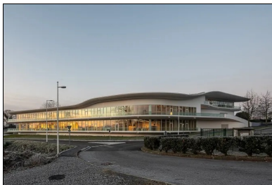
Façades nord et est entièrement vitrées offrent aux salles attenantes un accès direct aux coursives.
