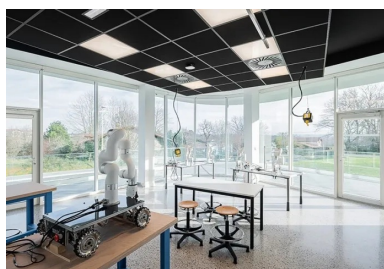
Dans toutes les salles, les sols en béton poncé allient esthétique, inertie thermique et pérennité.
