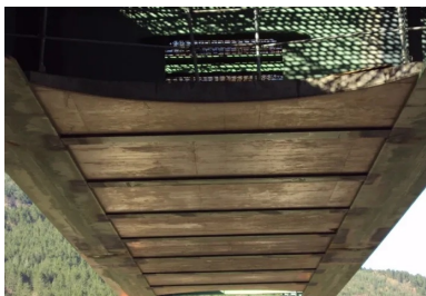
Prédalles participantes du hourdis inférieur - phase de lancement de la charpente. Mises en place avant le lancement, elles serviront de fond de coffrage lors du coulage du hourdis inférieur. ©CEREMA
