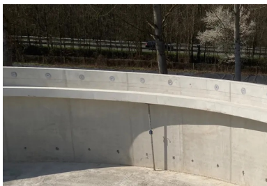
Les radiers de chaque bassin ont été coulés en une fois. Ils sont fondés sur des pieux en béton de grande capacité portante, réalisés selon la technique du refoulement de type INSER ©
