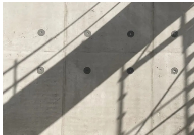
Le ciment des bétons des bassins contient une faible proportion de clinker. Cette formulation, choisie pour satisfaire des critères d'abord techniques, donne une teinte claire et esthétique à l'ouvrage.
