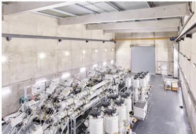
Vue du PSEM (poste sous enveloppe métallique) dont les parois en béton brut reçoivent une lasure incolore en guise de protection anti-poussière.
