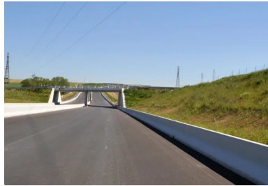
De nombreux ouvrages ont dû être installés pour permettre de maintenir une continuité écologique autour de la nouvelle route et garantir le déplacement de la faune locale.
