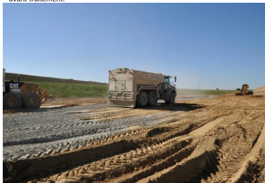
Après scarification, épanchage du liant hydraulique routier.
