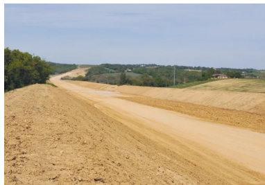
Vue du chantier
