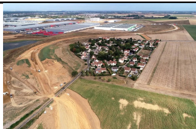
Une plate-forme support de chaussée innovante
