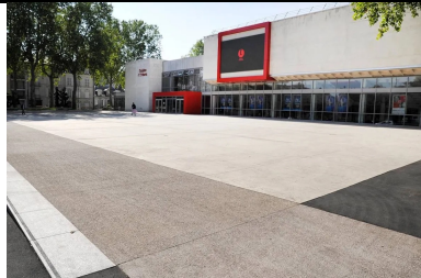
Orléans : deux belles réalisations en béton décoratif dans la cité de Jeanne d'Arc
