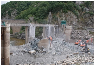
100 % du béton de la déconstruction sera transformé en granulats et réutilisé dans la future voie d'accès.
