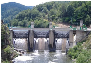
Avec ses trois vannes et ses passerelles, l'ancien barrage mesurait près de 20 m de hauteur.
