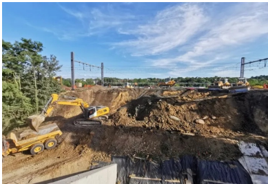
L'une des premières actions de l'opération coup de poing (OCP) a consisté à créer dans le remblai ferroviaire la brèche nécessaire à l'insertion du pont-rail. 13 000 m 3 de terre ont ainsi été déblayés en 24 heures.
