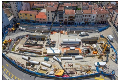
© ACTOPHOTO Station Oullins Centre : l'emprise du chantier est à peine plus grande que la dalle de couverture de la gare.
