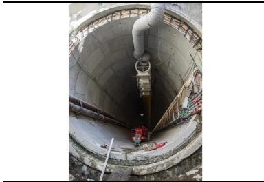
© SYTRAL (MOA) Le tunnel compte cinq typologies d'anneaux, chaque anneau étant composé de sept voussoirs en béton armé, tous de géométries différentes.
