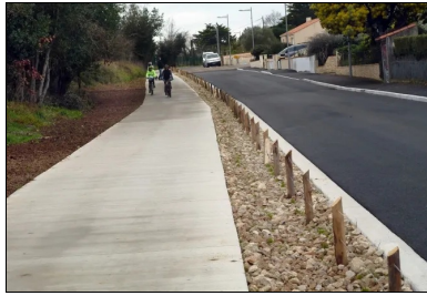
La noue sépare la piste cyclable de la chaussée rénovée.
