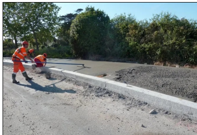
Talochage de la surface du béton.
