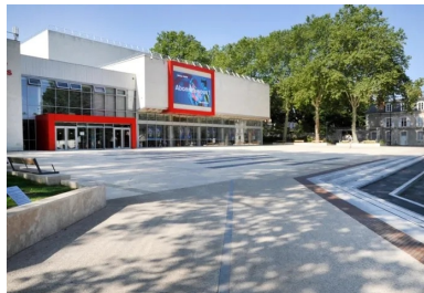
Le nouveau parvis en béton met en valeur la façade rénovée du théâtre. Conçu par le cabinet d'architecture Heudé et Heudé, elle est ornée de deux cubes rouges : l'un au niveau de l'entrée et l'autre accueillant un écran LED de 30 m 2 annonçant la programmation.
