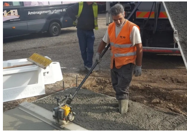
Le béton pompé a été réparti et étalé manuellement, puis vibré à la règle vibrante pour assurer son bon serrage.
