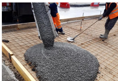
Réalisation des dalles de transition.
