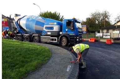
Le giratoire a été doté de nouvelles bordures dont les fondations ont été renforcées pour éviter les retournements.
