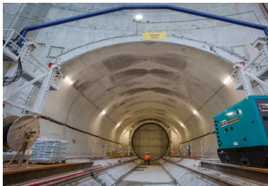
Amorces d'un tunnel réalisées depuis le puits.
