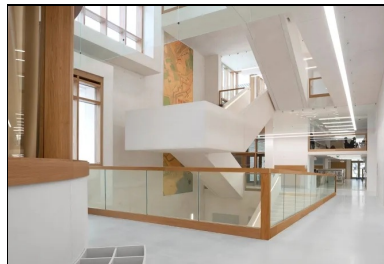
Le béton mis en œuvre est un béton blanc. Pour les architectes, le blanc est la couleur de Toulon. Ici, sa teinte subtile est à la fois douce et chaleureuse. ©S.Demaillly
