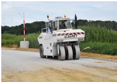
Un compacteur à roue réalise compactage final.
