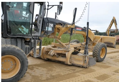
Un préréglage a été effectué à la niveleuse asservie GPS de façon à obtenir une épaisseur homogène préalable.
