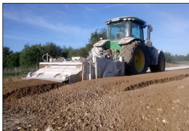
Le malaxage de la première couche est effectué avec un pulvimixeur de l'entreprise Brunner, sur une profondeur de 30 cm et une largeur de 1,80 m. Il nécessite trois passes complètes.
