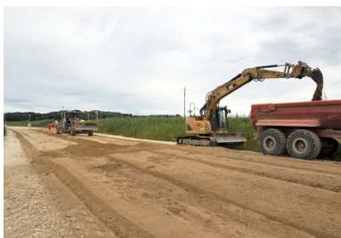
Les déblais, traités à la chaux, stockés et bâchés dans le périmètre du chantier, sont repris pour la réalisation de la couche de forme.
