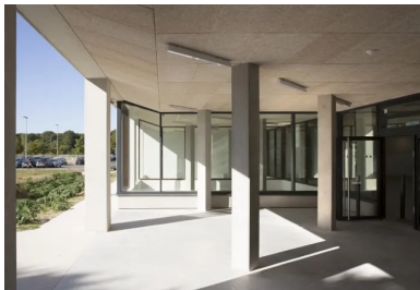
Vue sur un préau d'accès.
