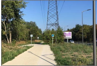
La ligne à haute tension surplombant la piste cyclable et la bande piétonne.
