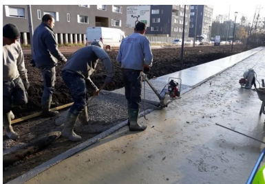
Le tirage du béton au rouleau Striker. Il n'a pas été vibré pour ne pas faire descendre le granulat, qui doit rester en surface pour le bon aspect visuel de la finition piquée.
