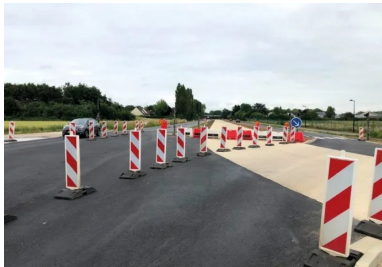
Le franchissement du giratoire des Deux-Plessis, à l'intersection de l'avenue du 8-Mai-1945, de celle des Régailles et de la rue de la Grange à Savigny-le-Temple.
