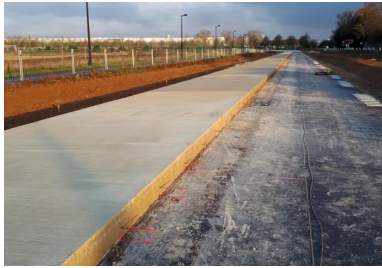
Afin de maintenir fermé le joint longitudinal, des fers de liaison ont été insérés dans le béton frais avec un espacement d'un mètre.
