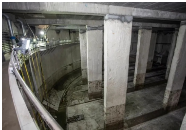
Après avoir réalisé le bétonnage de la paroi moulée du bassin, 22 "poteaux-barrettes" ont été coulés sur lesquels vont se poser les poutres préfabriquées en béton qui supportent la couverture
