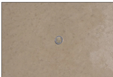
Aspect du BAC après lissage à l'hélicoptère.
