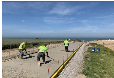
L'épandage du béton s'effectue à l'aide de différents outils : rateau, épandeur ou lissarde.
