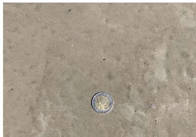
Aspect du BAC après pulvérisation du produit de cure.
