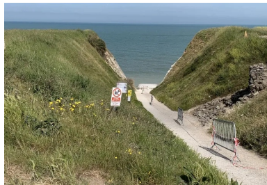
L'aménagement est destiné à permettre aux visiteurs d'accéder facilement à la plage située aux pieds des falaises.
