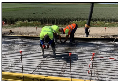
Après avoir posé les armatures longitudinales sur les distanciers, l'équipe les ligature avec un recouvrement de 64 cm.
