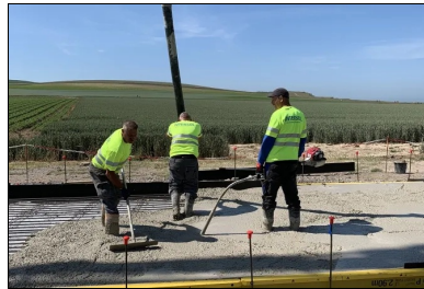
Bétonnage : alimentation du béton à la pompe, réglage au rateau, suivi du serrage du béton à l'aiguille vibrante.
