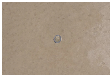
Aspect du BAC après lissage à l'hélicoptère.
