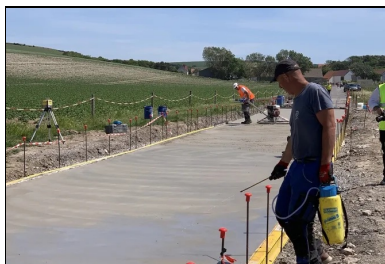
Pulvérisation d'un produit de cure à la surface du béton frais pour le protéger de la dessiccation.
