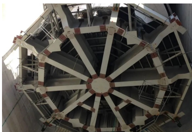
Le four solaire commence son ascension, hissé par vingt vérins à l'aide de câbles.
