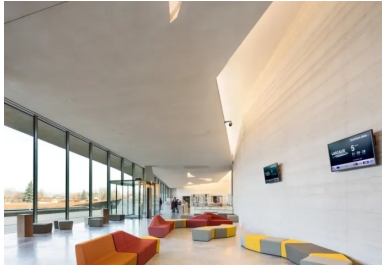
Dans le hall qui communique avec les salles d'exposition, la stratification imprimée au béton reste bien lisible.
