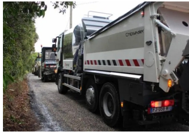
Difficulté : l'étroitesse des voies (< 3,50 m).
