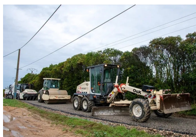
La niveleuse, le cylindre V4 et le compacteur à pneus.
