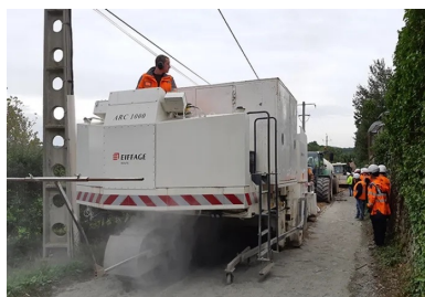
La chaussée est décohésionnée et malaxée.
