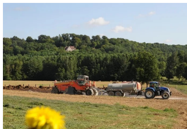
Technique éprouvée, le retraitement en place au LHR combine intégration écologique et respect du site, en évitant notamment l'extraction et la mise en décharge des matériaux pollués par une noria de camions
