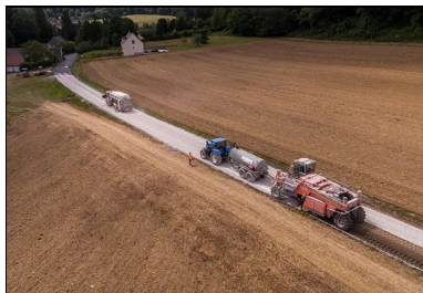
Atelier de retraitement en action
