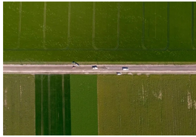
L'ARC 1000 assure le malaxage du liant avec le fraisat d'enrobé et les matériaux de l'ancienne chaussée sur une profondeur de 25 cm (dans l'axe de la chaussée) et de 30 cm en rives. L'ajustement de la teneur en eau est apporté par injection directe dans la cloche de l'ARC 1000 grâce à une citerne d'eau.
